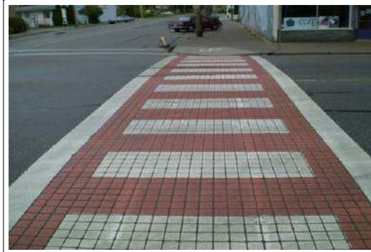
passaggio pedonale rialzato
